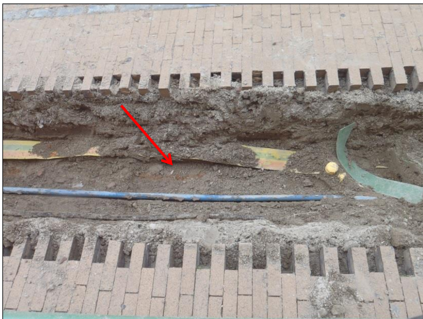
Afbeelding 2. Situatie na verwijdering van de bestrating. Bij de rode pijl is de bovenkant van de oude gietijzeren gasbuis te zien
